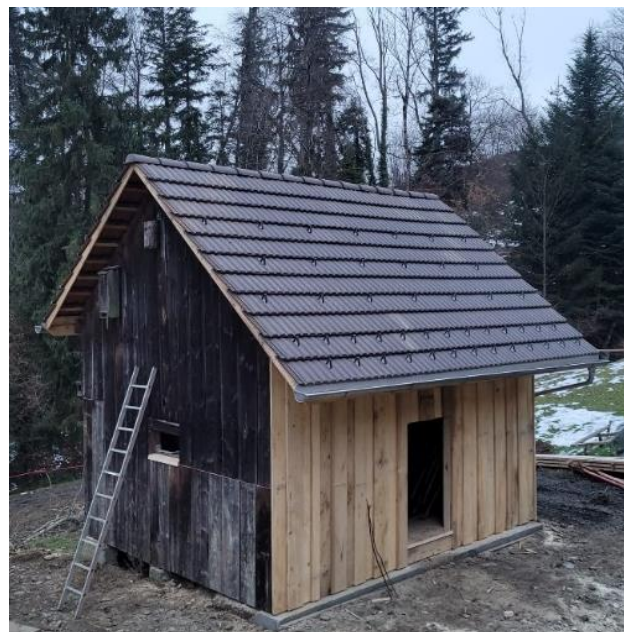
Abbildung 1: Waldhütte, neu instandgesetzt
